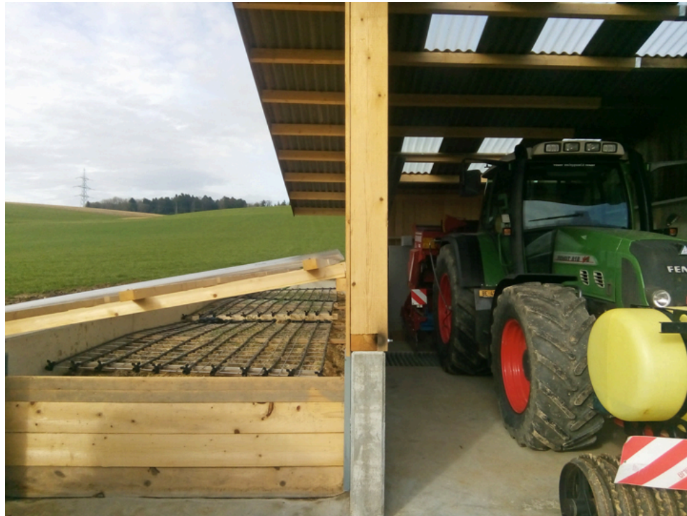
Füll und Waschplatz (rechts) mit Verdunstungsanlage (Biobed) in «Fahrsilo»-Form (links), Schlammsammler und Puffertank unterflur
