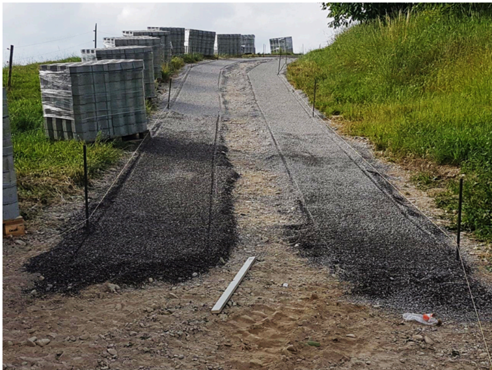
Vorbereitung für das Versetzen der Rasengittersteine. Ein negatives Dachprofil leitet das Wasser zu einer wasserführenden Mittelrinne ab.
